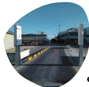
Portique de sortie de zone Saphygate Saphygate zone exit gantry
